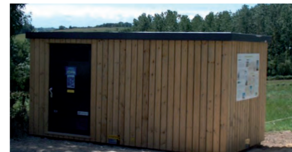
PRINCIPE DE BARDAGE BOIS JOINTIF
